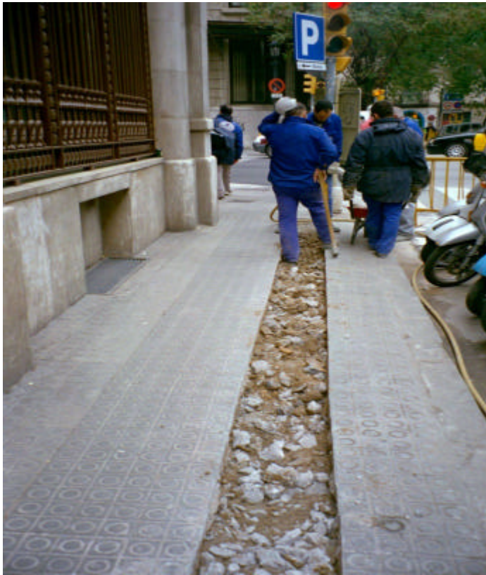
Foto 1. Obertura de la rasa 1 (UE 100).
